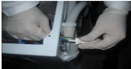
Démonter le pressostat EPS
